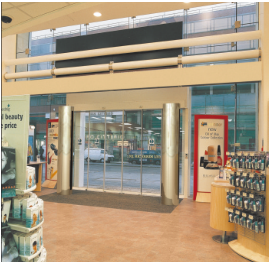
Завесы серии AD Коринта могут устанавливаться вертикально и горизонтально. Четыре типоразмера моделей по длине позволяют сделать оптимальный выбор для проемов любой ширины.
